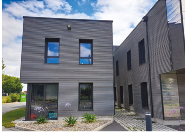
Extension du bâtiment de la direction déchets
