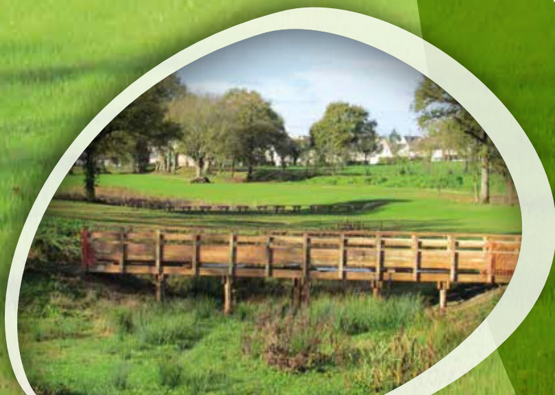
Des traversées en platelages bois permettant de découvrir l'environnement naturel
